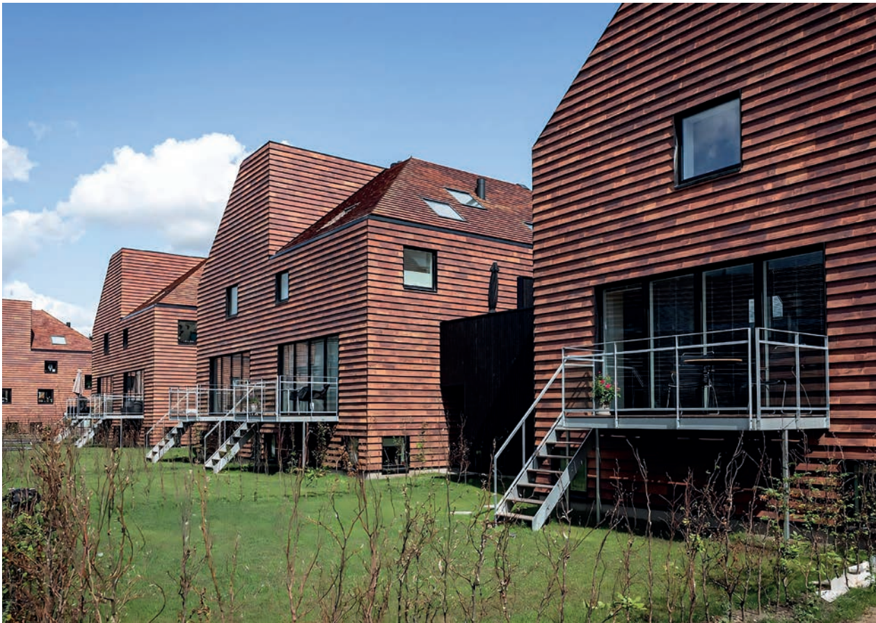
Thors Høve Silkeborg, Denmark — SK1N Terra PG
